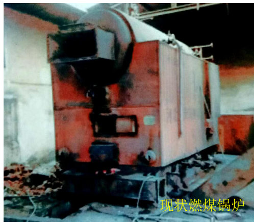
图 7 锅炉房现状图
